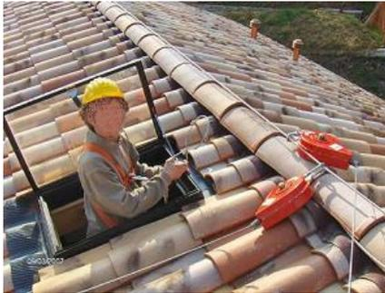
Accesso alla copertura tramite abbaino. L'apertura da cui deve essere effettuato l'accesso è riportata sulla planimetria in possesso del proprietario dell'edificio. L'utilizzatore, in questa fase, deve avere indossato adeguati DPI (imbracatura e cordino di trattenuta )
