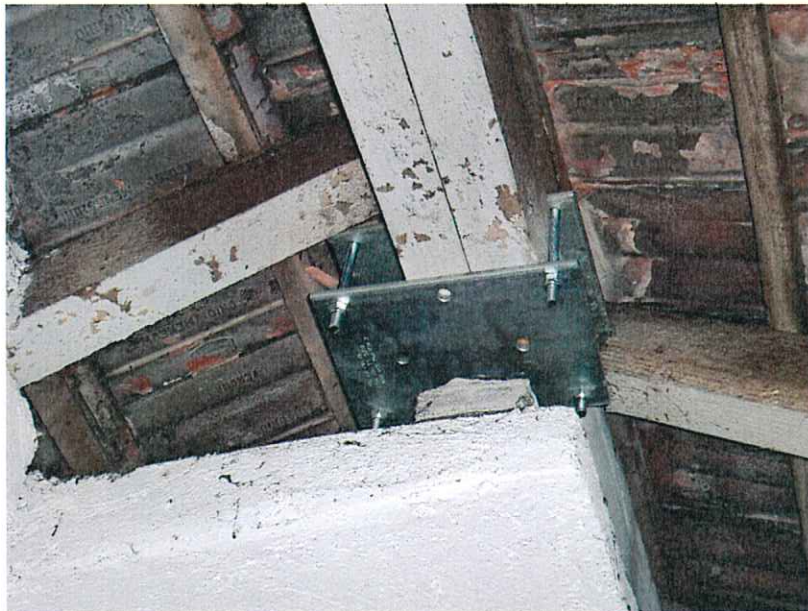
Figura 9: immagine della posa palo tipo ASF2 con contro piastra
